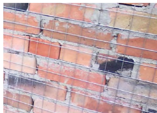
Армирующая металлическая сетка
