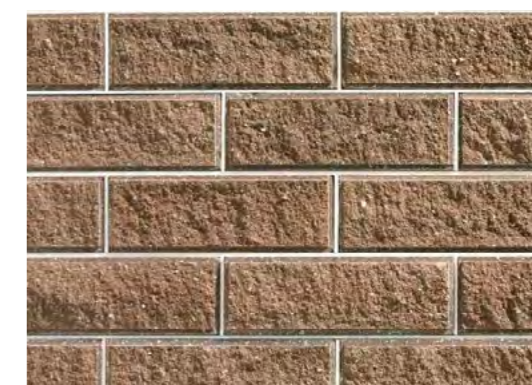
Укладка плитки с расшивкой
