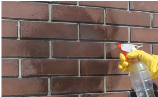
Нанесения гидрофобизатора распылителем
