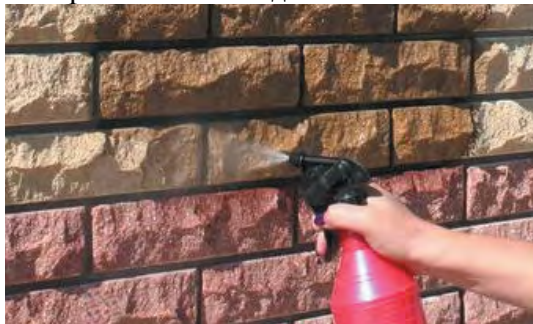
Нанесения гидрофобизатора распылителем
